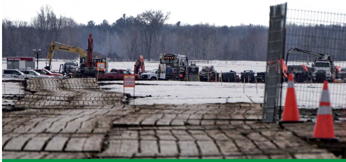
Excavations à Mirabel en mars 2018 pour nettoyer "une tache" selon Enbridge. PHOTO : ALEXANDRA WHITE
